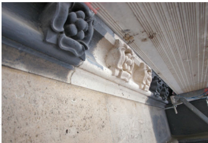
Vor und nach der Reinigung: Unter der Schmutzkruste ist die Steinsubstanz weitgehend intakt.
